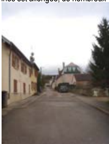
Constructions anciennes mitoyennes
