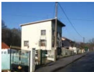
Construction à proximité de la voie ferrée
