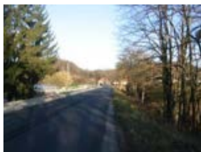
Entrée Sud (RD.105)
